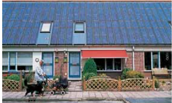
ألواح شمسية تغطي سطح هذا المنزل في هولندا، على الرغم من كونه بلداً قليل الشمس.
